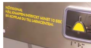
Exempel brailleskrift och text vid nödsignalknapp. OBS ej Braille i knapp.
