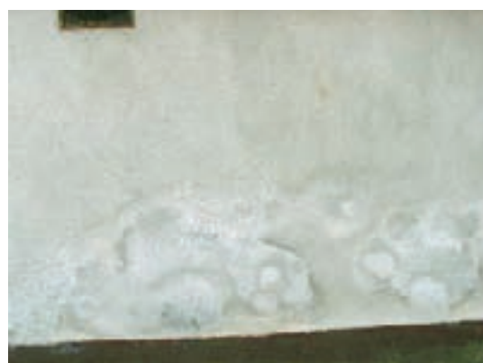
Cementlagningar kan bidra till att det bildas vita saltringar på den gamla putsen.
