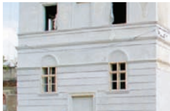
En brädriven yta kan bli mycket jämn och rak och det används när man vill skapa en slät lodrät yta.
