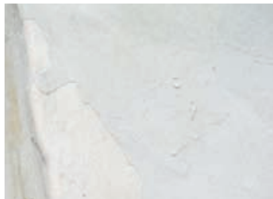
Både kalkfärg och KC-färg som innehåller ballast kan lätt skikta sig och lossna från ett underlag som är alltför slätt.
