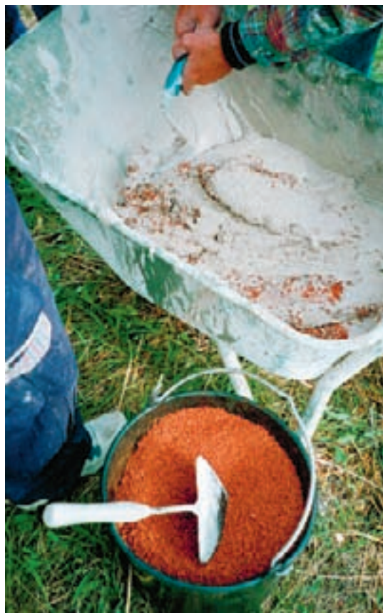
Tillsats av krossat tegel ger ett svagt hydrauliskt bruk.
