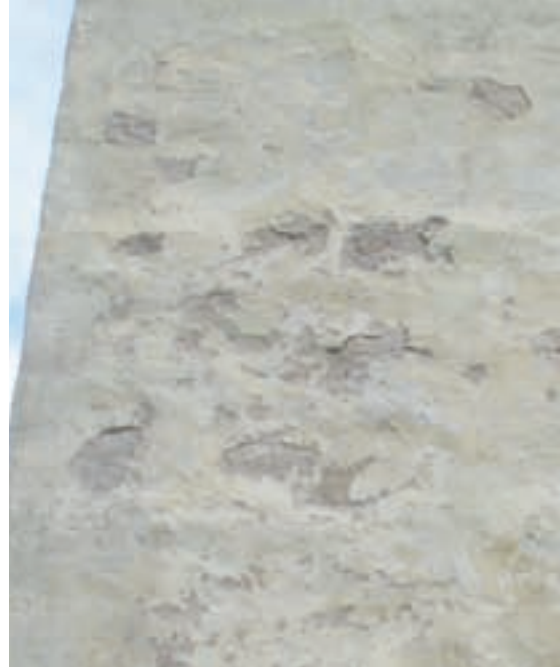
Modern hydraulisk kalkputs på Örgryte gamla kyrka i Göteborg.
