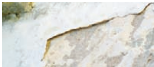
Ett KC-bruk som arbetat sig loss från underlaget är relativt enkelt att avlägsna.
