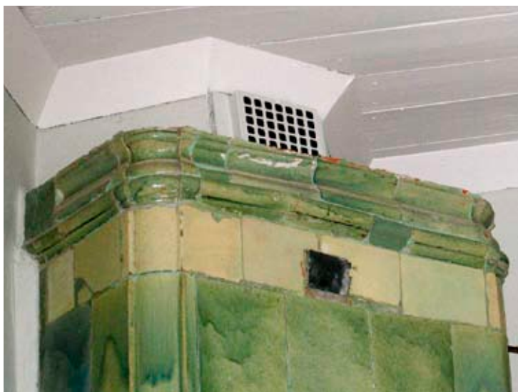
Eftersom de gamla rökkanalerna inte längre används för eldning så har kakelugnarna plomberats och frånluftsgaller monterats rakt in i kanalen ovanför kakelugnen.
