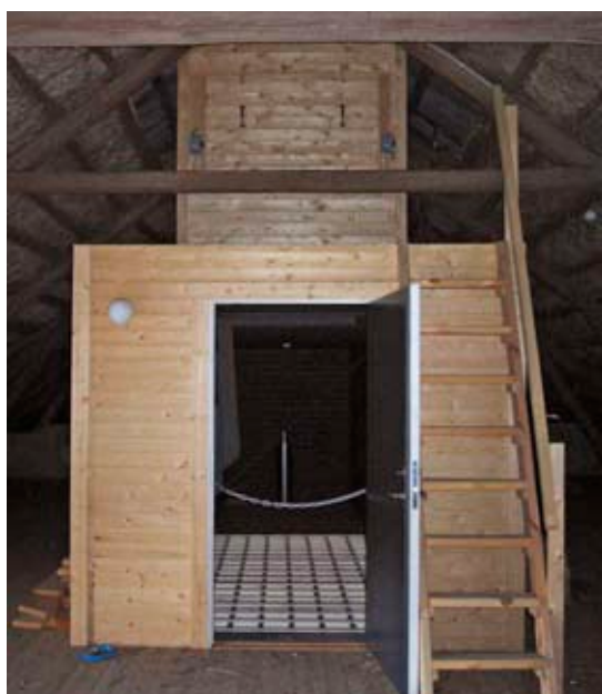
De nya frånluftschakten såväl som vindsbjälklaget är isolerade. På så vis har man undvikit att isolera yttertak som har skyddsföreskrifter och ej får förändras.
