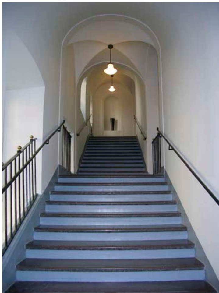
Via trapphuset stiger tilluften vidare uppåt i byggnaden och ventilerar alla rum.
