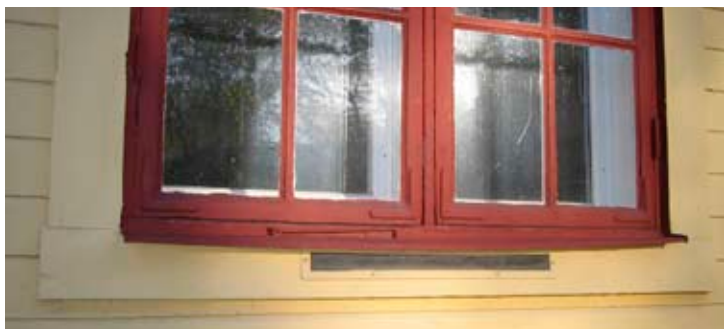
Luftintag under fönsterblecket.
