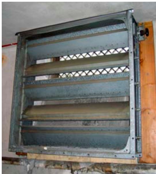
Här tas luften in till kaloriferkammaren. Spjället är manuellt ställbart för önskat luftflöde.
