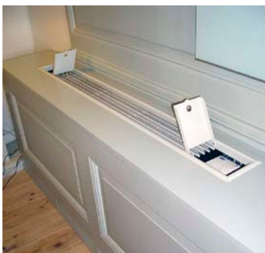
Sammanträdesrummen och vissa kontorsrum och korridorer har specialutformade kanalisationsbänkar med fancoil, dvs. fläktar som antingen sprider uppvärmd eller kyld rumsluft.
