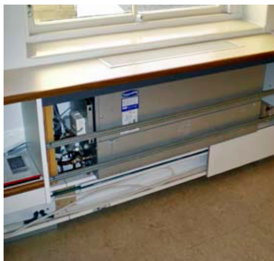
Fläktkonvektor s. k. fancoil, med värme- och kylbatteri. Rumsluften kan antingen tillföras kyla eller värme. På denna bild är frontskivan bortlyft.
