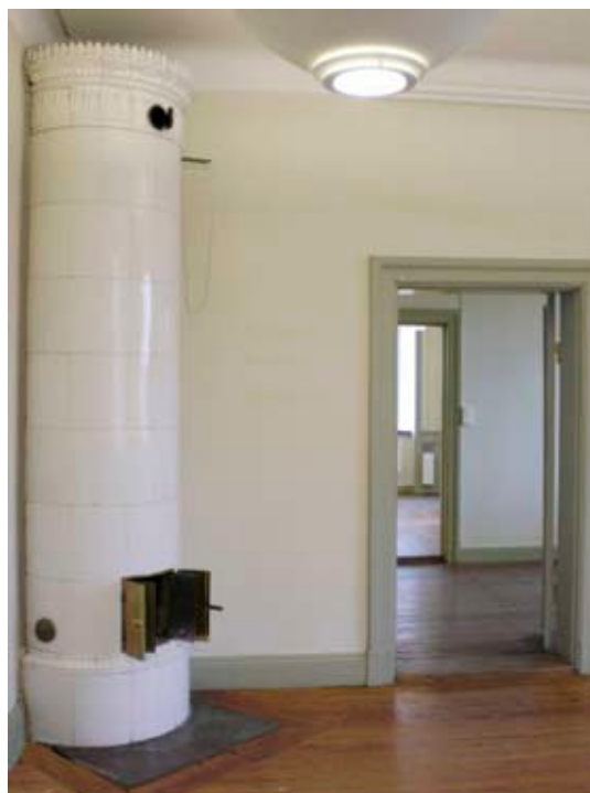
Byggnaden har generösa rumsvolymer med "rum i fil". De kakelugnar som finns kvar har proppats för eldning. Rökkanalerna används för frånluft.
