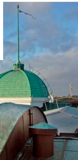
Närmast syns Munchsalens tak med frånluftshuv, längre bort kupolen. Lilla bilden visar kupolens frånluftöppning.
