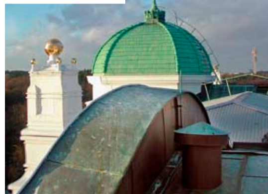
Närmast syns Munchsalens tak med frånluftshuv, längre bort kupolen. Lilla bilden visar kupolens frånluftöppning.
