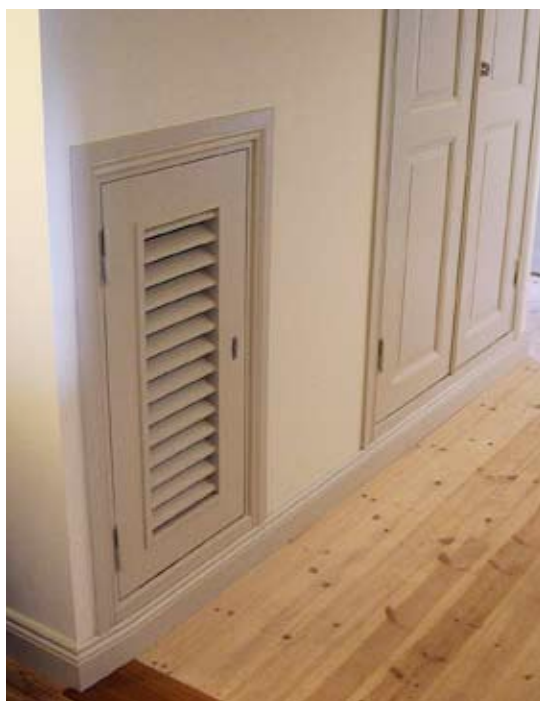
Tilluften, förvärmad eller kyld, kommer in via specialdesignade galler av trä utformade att passa in i byggnadens snickerier.
