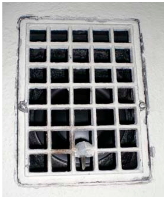
Bakom frånluftsgallren sitter kontrollventiler för injustering av frånluftsflydet
