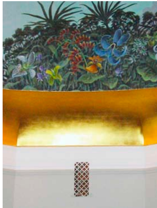
Frånluftsgaller i tornrummet. 1978 utförde Karl Axel Pehrson denna kupolutsmyckning.
