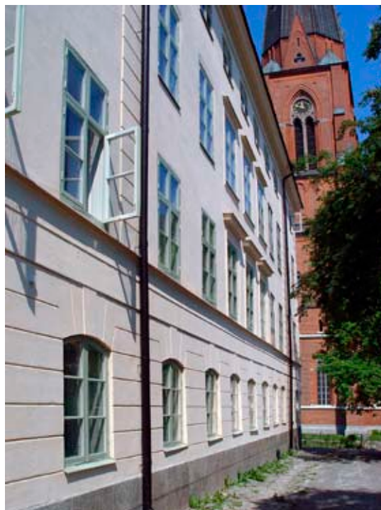
Sommartid är fönstervädning alltjämt ett uppskattat tillskott till den mekaniska ventilationen.
