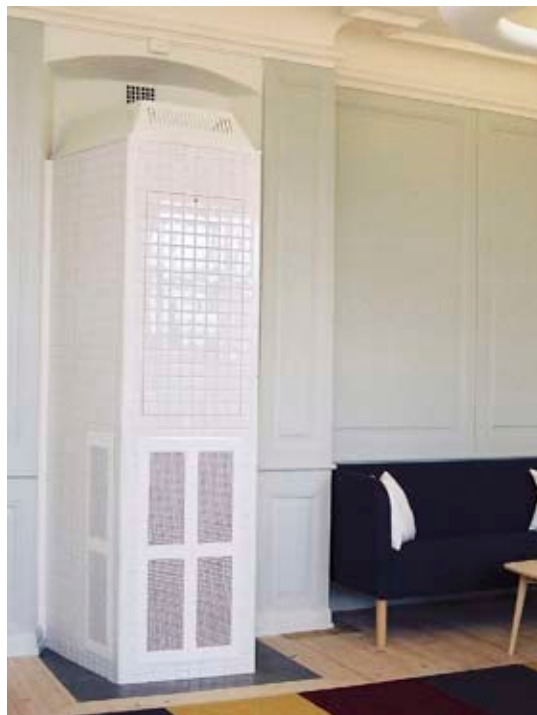
Denna nya fläktlufts kylare har utformats för att likna en kakelugn och bättre passa in i miljön.
