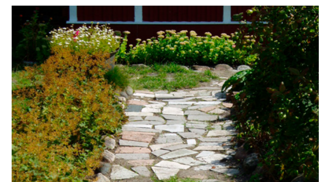
Gång i kalkstensplattor och rad med kullersten som kantstöd.
