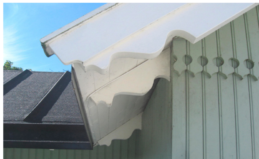
Vackert bearbetad takfot och dekorativt gavelstycke i pärlspånt på en av kolonistugorna. Taket klätt med tjärpapp monterat på trekantslister.
