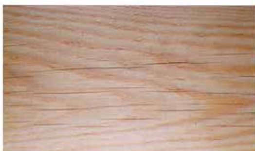
Torkspricka, krympspricka, småsprickor i ytan (fig 28)
