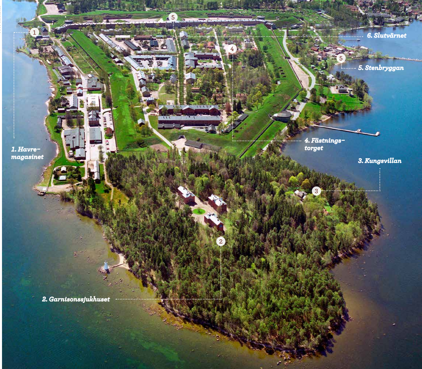
Karlsborgs fästning ligger på Vanäs udde vid Vättern. I det mångfacetterade området finns cirka 170 byggnader.
