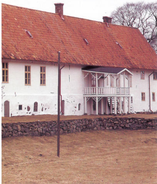
På borgholmen, som tidigare var omgiven av vattenfyllda vallgravar, ligger mangården. Stenhuset till vänster byggdes 1805, medan den vitputsade längan, som är det egentliga boningshuset, byggdes 1681–82.
