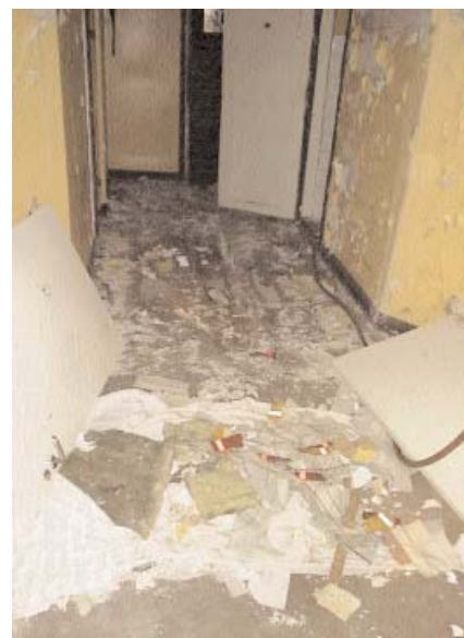
Då renoveringen inleddes var byggnaden i mycket dåligt skick. Alla bjälklag utom de på vinden var angripna av hussvamp och alla invändiga ytor var starkt mögelanlupna.
