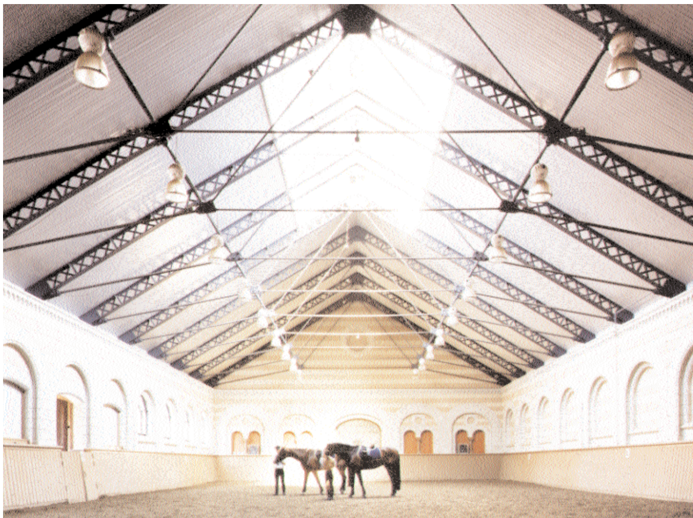
Ridhuset med sin blandning av stram klassicism och funktionell gjutjärnsarkitektur har fått ett underlag av sand och oorganiska fibrer för hästarna att springa på.
