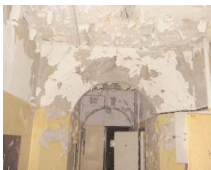
Då renoveringen inleddes var byggnaden i mycket dåligt skick. Alla bjälklag utom de på vinden var angripna av hussvamp och alla invändiga ytor var starkt mögelanlupna.
