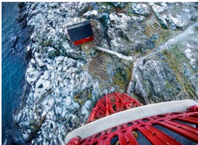
Den 32 meter höga fyren är en så kallad heidenstammare som stagas upp av snedställda rör.
