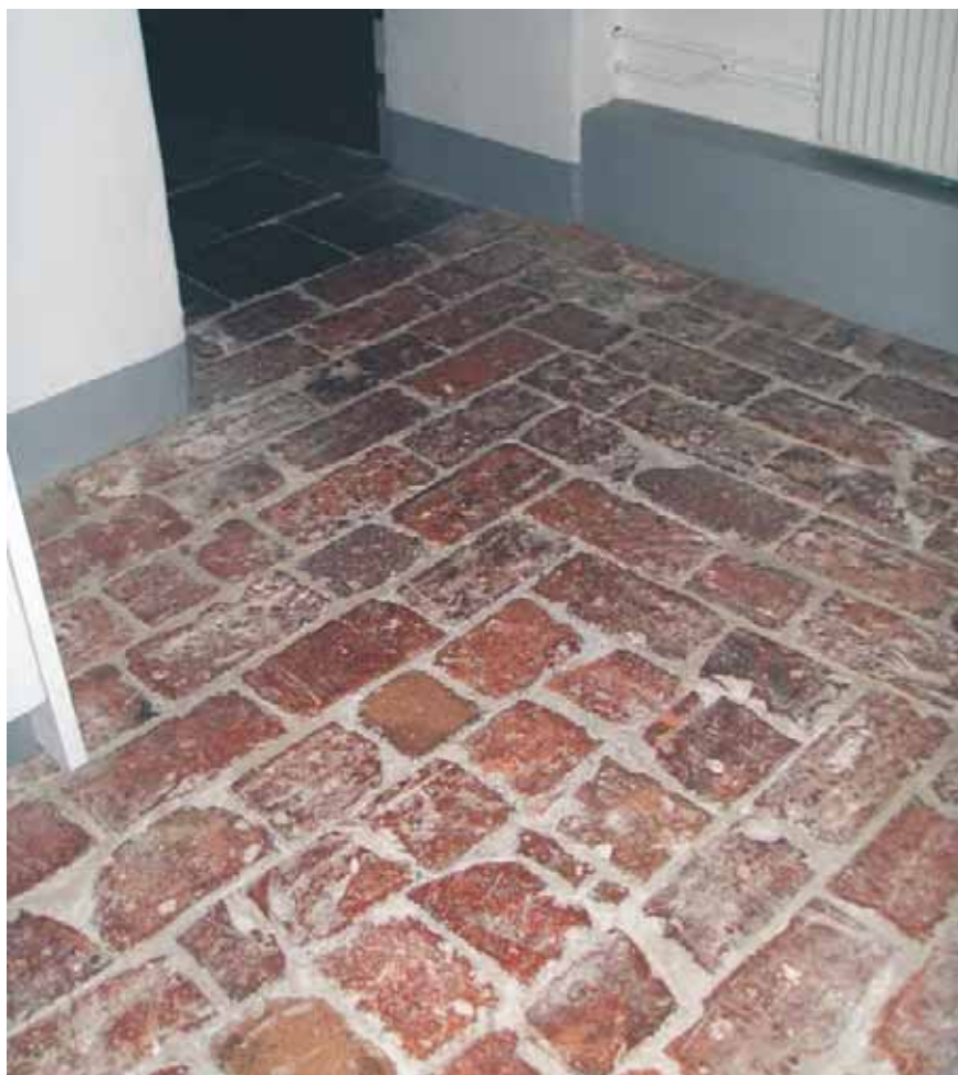
Tegelgolv med lösa fogar i Södra Bankohuset.
