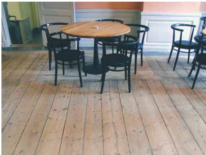
Såpaskurat trägolv i personalköket i Södra Bankohuset på SFV:s huvudkontor.
