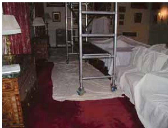
En rullställning bör ha stora hjul som inte skadar underlaget. FOTO: LISA NILSEN.
