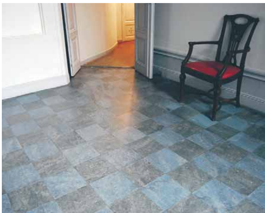
Bilden visar ett exempel på ett välskött mönsterlagt linoleumgolv som är från 1940-talet. I det närliggande rummet anar man en linoleummatta i ekimitation.
