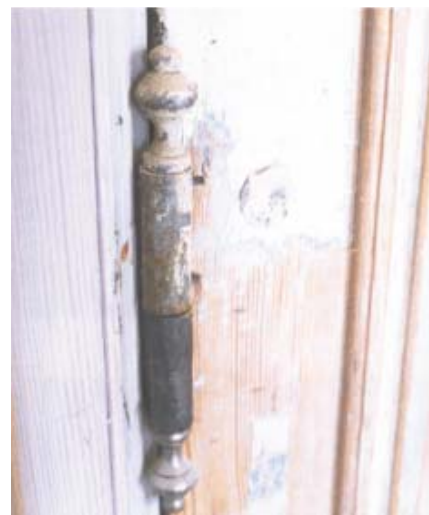
Gångjärn och beslag har återanvänts och kompletterats med nytillverkade delar.
