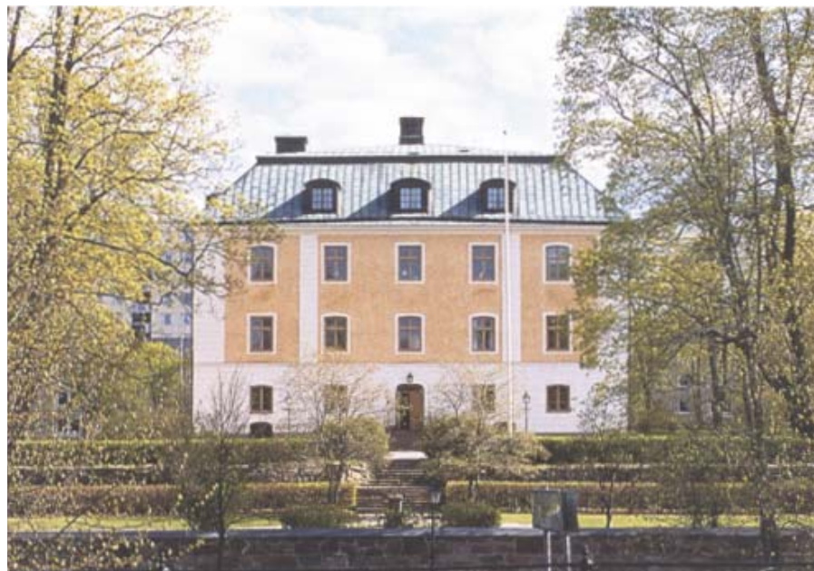
Gävle slott fick sitt låga mansardtak, med plåt på de övre och tegel på de nedre takfallen, efter Hårlemans ombyggnad.
