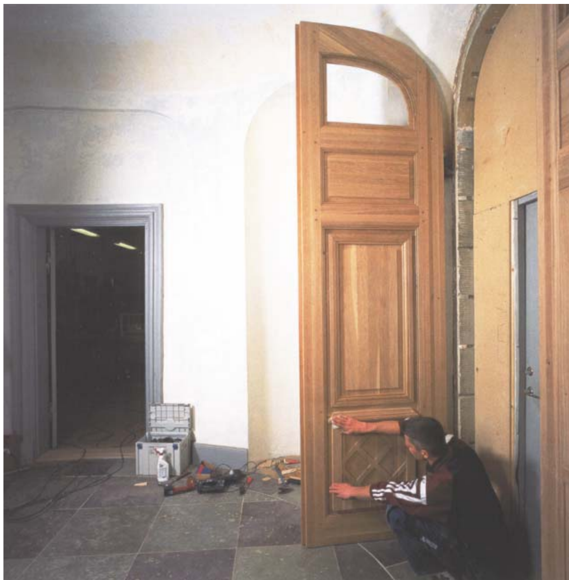
Portarna som byttes ut under fängelsetiden har rekonstruerats och nyttillverkats i ek. De kommer senare att målas med oljefärg.
