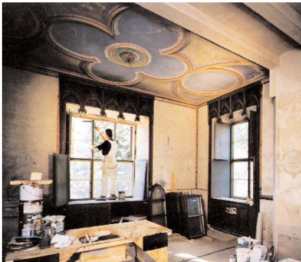
Vid ombyggnaden av Bogesund på 1860-talet inreddes en matsal i nygotisk stil. Under slottets period av förfall skadades rummet svårt och bland annat störtade delar av taket in. Rummet restaureras nu till sitt ursprungliga utseende.
