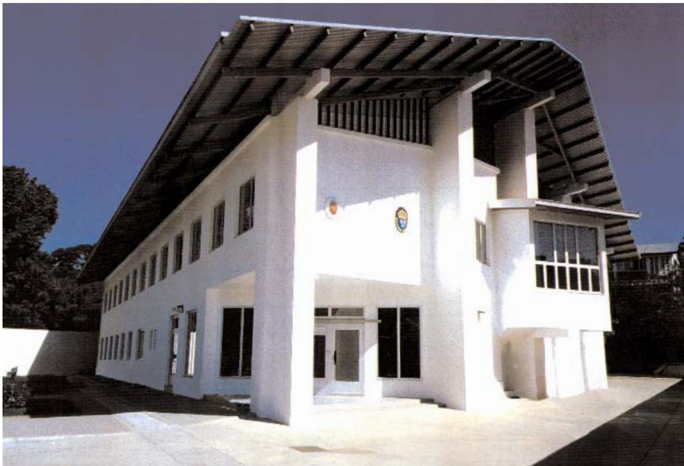
Sveriges och Finlands nya ambassadbyggnad i Dar es Salaam. Arbetsrummen längs sidofasaderna skuggas av de stora takutsprången.
