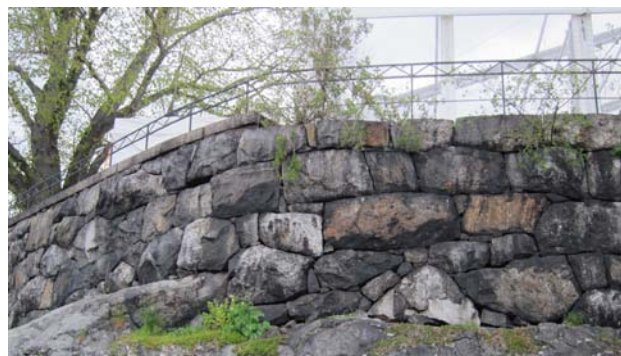
Kallmur på Waldemarsudde byggd med stor hantverksskicklighet.
