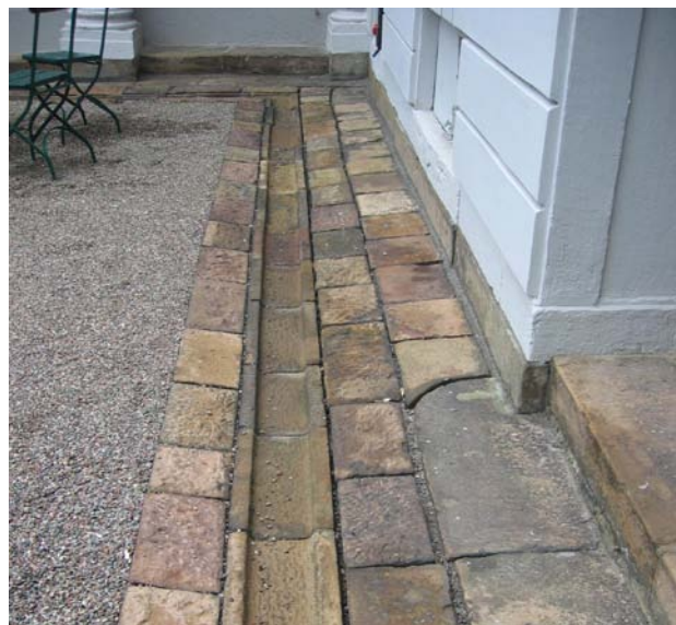
Beläggning och rännal av sandsten på Tessinska palatset.
