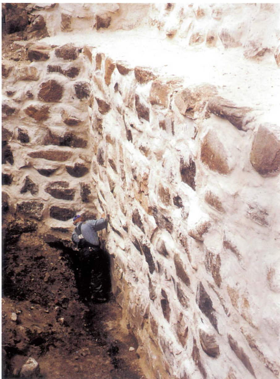
Omfogning av inre skalmuren.
