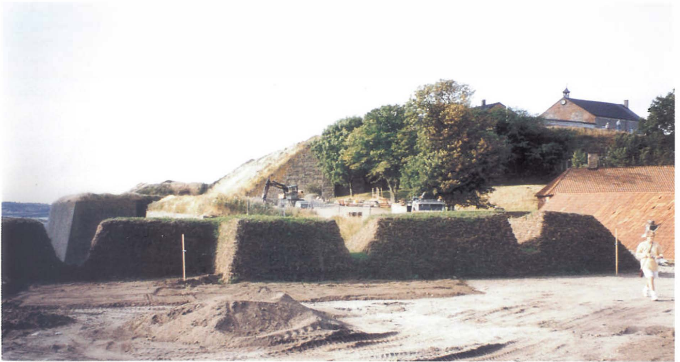
Bastion Vita Munkens södra flank. Färdigställt bröstvärn med embrasurer.
