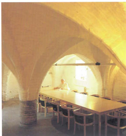
Biskop Henrik Tidemanssons borgstuga inreddes med ståtliga kryssvalv i slutet av 1400-talet. Den ligger i den del av slottets västra länga som byggdes på 1200-talet.
