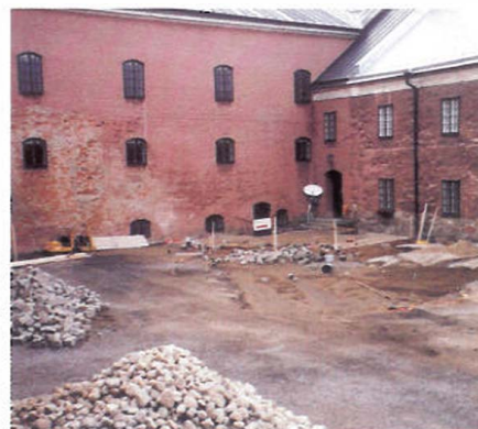
Borggården från norr, inför kullerstensläggning och fasadblästring.
