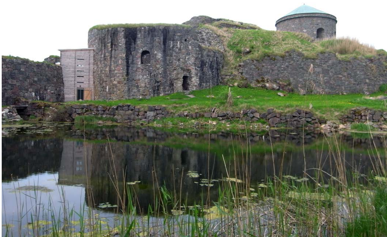
Bohus fästning i Kungälv med den nya hissbyggnaden i timmerkonstruktion.
