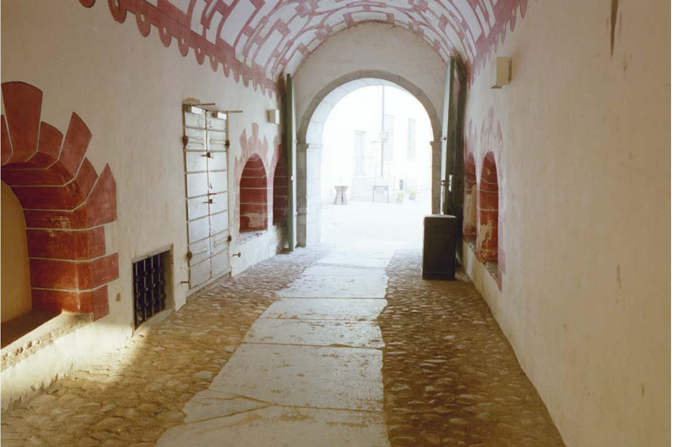
Efter: Nya breda kalkstenar har lagts i entrén till slottet.
