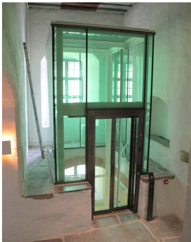
Efter: Hiss installerad i valvet i Kalmar slott. Hisschaktet är sprinklat och det gröna glaset kan motstå brand cirka trettio minuter.
