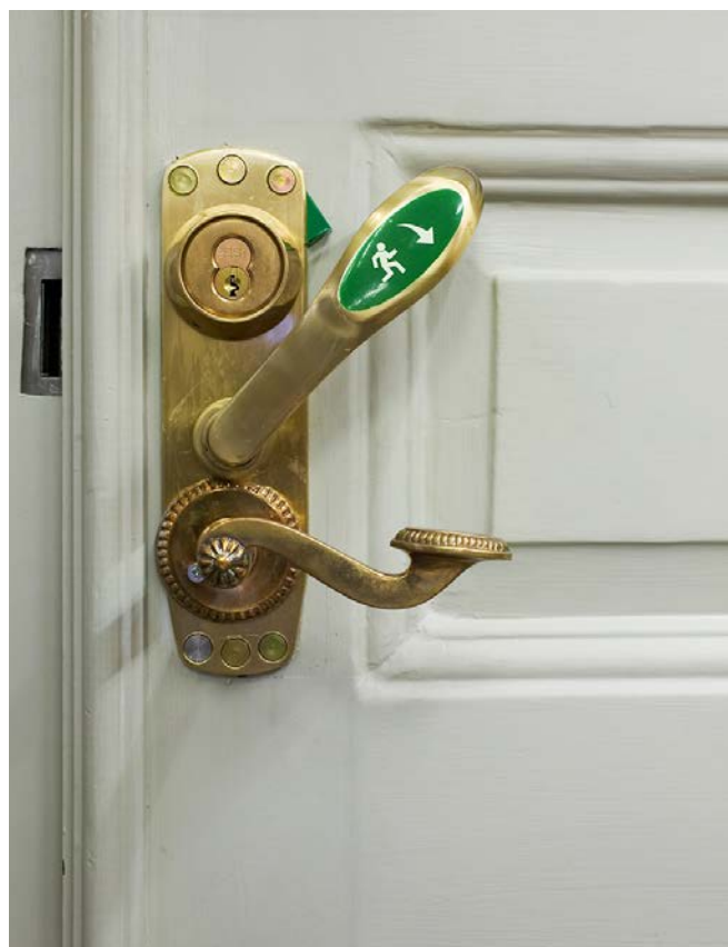
Utrymningsbeslag i kombination med gammalt trycke. Wrangelska palatset, Stockholm.
