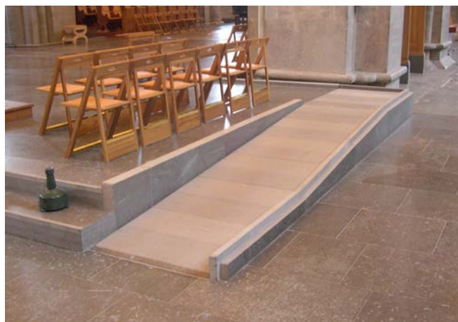
Ramp i det nya kalkstensgolvet i Linköpings domkyrka.
