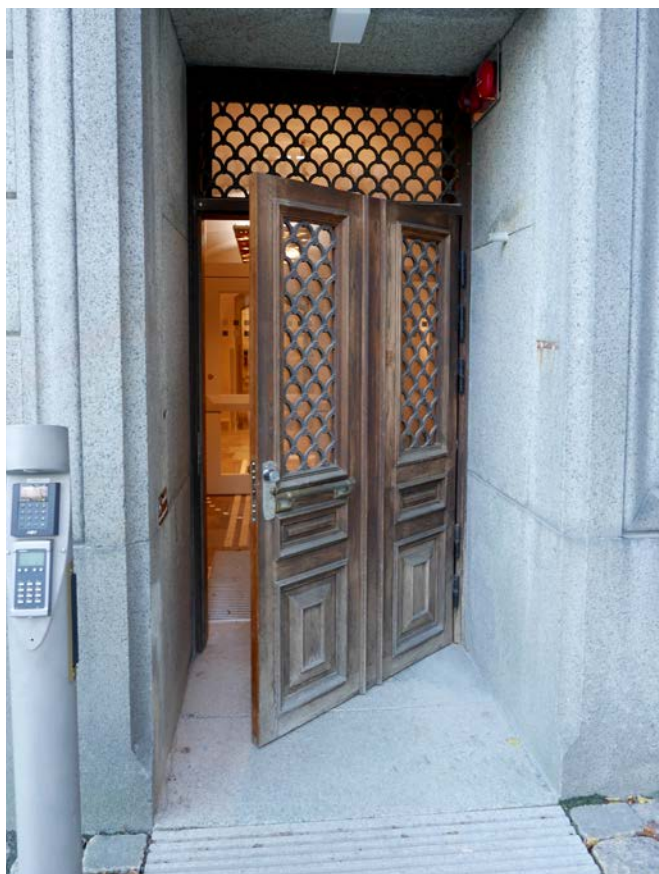
Entrédörren var tidigare en pardörr. Den har tillgänglighetsanpassats till en dörr med bredare passage.
