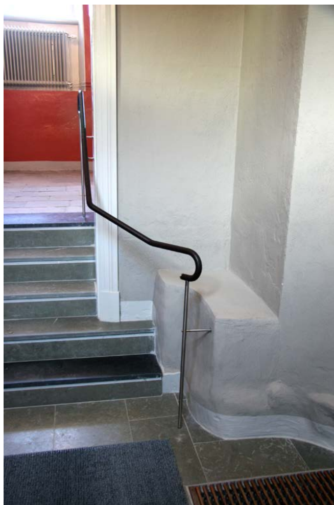
Trappan är breddad och har en ny ledstång, Linneanum i Uppsala.
