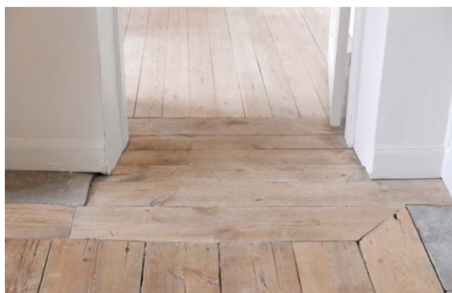
Tröskel borttagen i Södra Bankohuset.
