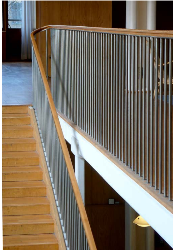
Kontinuerlig ledstång mellan våningsplanen med bra utformning för personer med nedsatt synförmåga. Tillbyggnad till Göteborgs rådhus av arkitekten Gunnar Asplund 1936, Göteborg.
