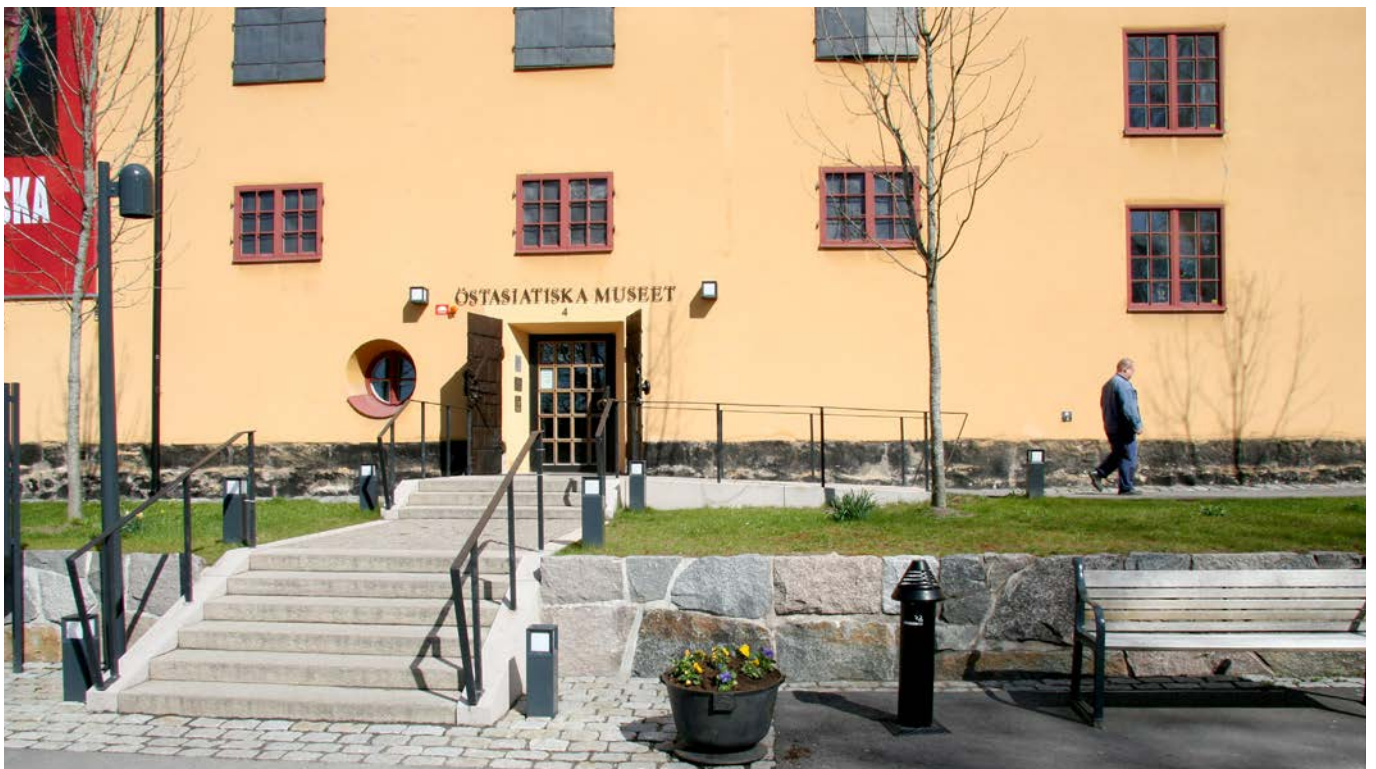
Gemensam trappa och ramp till huvudentrén till Östasiatiska museet på Skeppsholmen, Stockholm.
