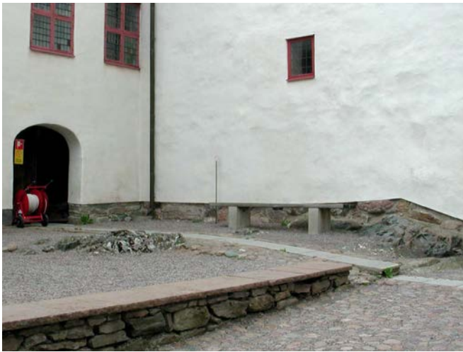
Före: Gångväg till toaletter på Läckö slott utanför Lidköping.
