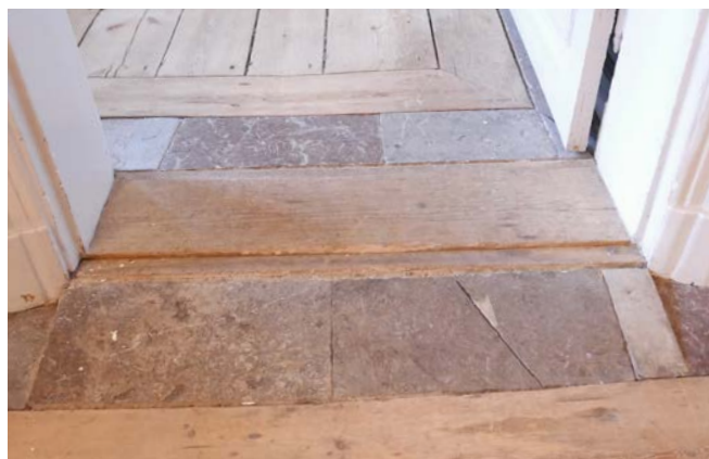
Stenfrisen uppinklad mot tröskeln i Södra Bankohuset.
