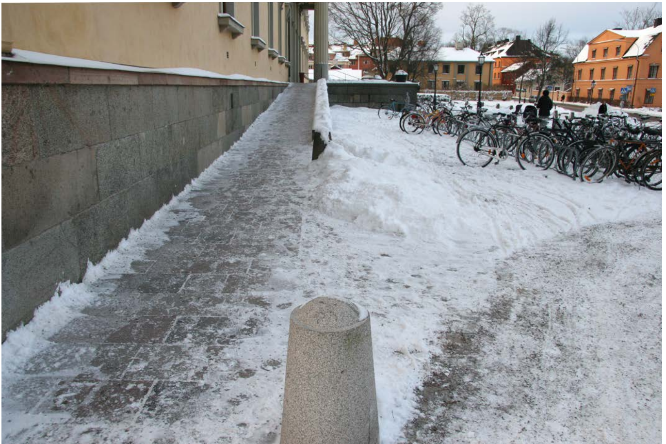
Vinterhållen ramp. Universitetsbiblioteket Carolina Rediviva, Uppsala.
