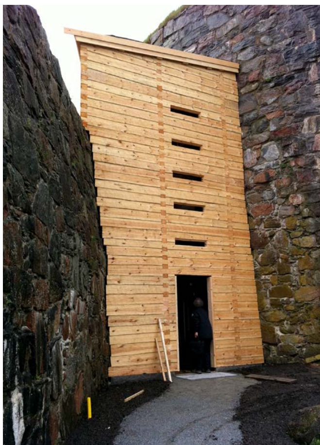
Hisstornet är byggt i en traditionell liggtimmerteknik.
