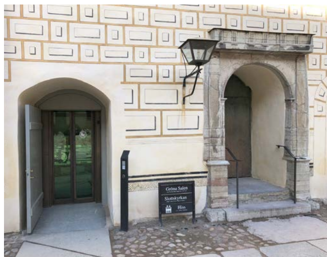
En ny hissentré genom murverket, i en tidigare igenmurad öppning, har placerats intill den nuvarande entrén.
